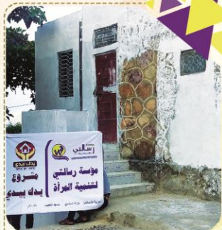
بناء مسجد الكفيف - الشمايطين
